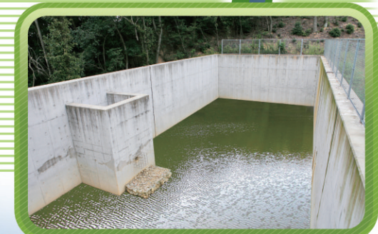
場内雨水排水処理施設（調整池）
